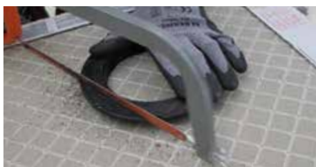
17. Retourner la base et enlever deux des côtés le long de la ligne prédécoupée.
