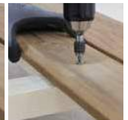
24. Atornillar el listón de madera en la viga que se encuentra debajo con un destornillador adecuado.
