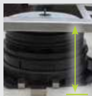
D4. Coupez le carreau de la même hauteur entre le profil BSJ et le clip SUPACLPB.
