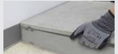
D-6. Colocar la baldosa.
