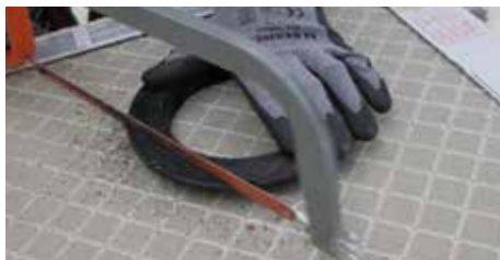
7. Dé la vuelta a la base y retire uno de los lados por la línea de corte.
