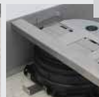
D3. Mettez le clip SUPACLPP et le profilé BSJ sur la tête du plot.
