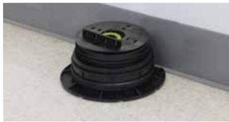
18. Montar el soporte y colocarlo con el lado cortado apoyado en la pared.
