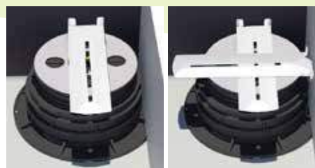
12. Colocar dos clips espaciadores SUPACLPP perpendiculares entre sí.
