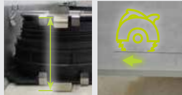
D4. Coupez le carreau de la mesure correspondante à la distance entre le clip SUPACLPT et SUPACLPB
