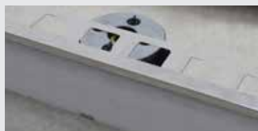
E-5. Encaje la baldosa cortada entre el perfil BSJ y el clip SUPACLPB.
