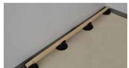
7. Comprobar que la viga esté firmemente fijada en todos los soportes.
