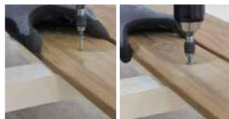
24. Visser la lame sur le liteau situé en dessous à l'aide d'une visseuse adaptée.
