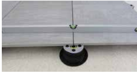
16. Verifique que el pavimento sea lineal.
