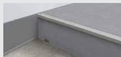
D6. Posez le carreau de couverture.
