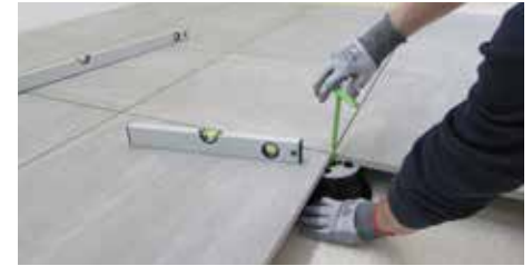
17. En cas de mauvais alignement, réglez la hauteur à l'aide de la clé SUPAK.
