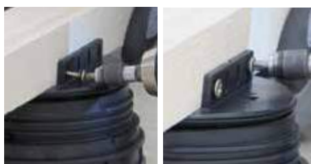
6. Atornillar la viga en el soporte a través de las correspondientes ranuras (utilizar un destornillador).
