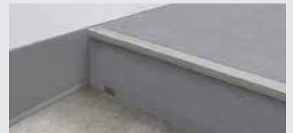
D-6. Colocar la baldosa.
