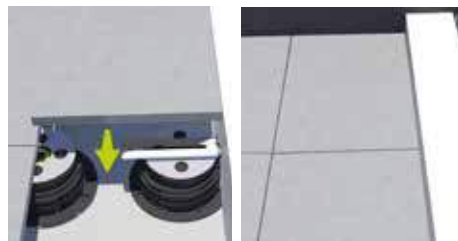
17. Colocar las baldosas.
