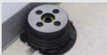
D2. Positionnez le plot mettant le côté coupé vers le mur et l'autre côté vers l'extérieur.
