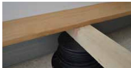
23. Colocar el primer listón de madera en contacto con la pared.
