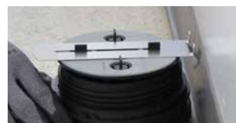
9. Fixez le clip d'espacement SUPACLPP entre les deux ailettes perpendiculaires au mur.
