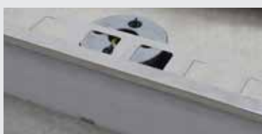
E5. Mettez le carreau coupé entre le profilé BSJ et le clip SUPACLPB.
