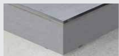
F6. Posez le carreau de couverture.
