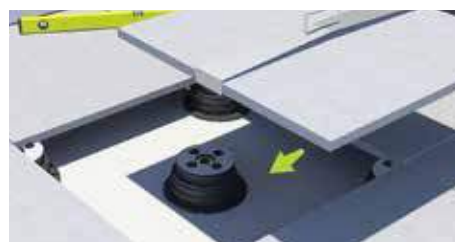
5. Mettre le carrelage en place.
