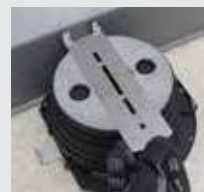
D3. Mettez le clip SUPACLPP et le profilé BSJ sur la tête du plot.
