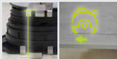
F-4. Corte la baldosa a la medida correspondiente entre SUPACLPB y SUPACLPT.
