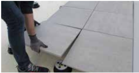
15. Posez les autres carreaux.
