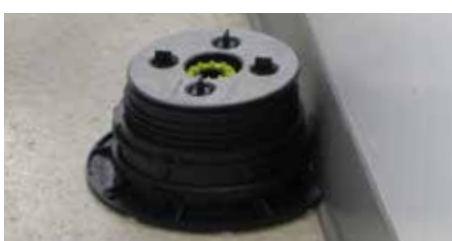
8. Assemblez et positionnez les plots avec le côté coupé appuyé contre le mur.
