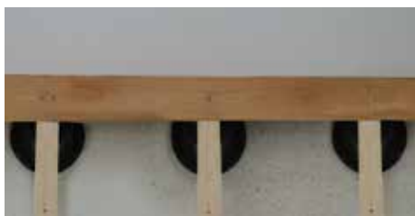
25. Poser la première rangée de lames en bois en les vissant aux endroits où elles reposent sur le liteau en bois situé au-dessous.
