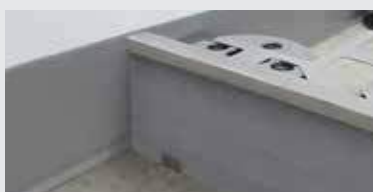
D5. Mettez le carreau coupé entre le profilé BSJ et le clip SUPACLPB.
