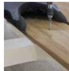
24. Atornillar el listón de madera en la viga que se encuentra debajo con un destornillador adecuado.
