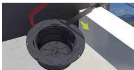
13. Cortar un lado del soporte.
