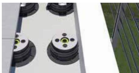
14. Colocar el soporte con el lado cortado en contacto con la pared.
