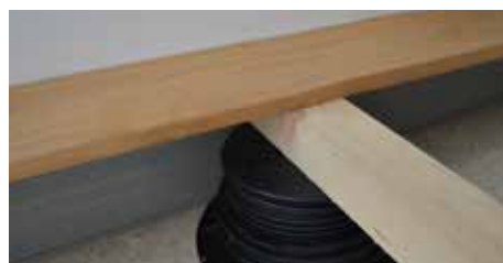
23. Placer la première lame de bois au contact du mur.
