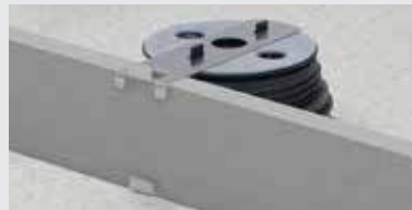
E-5. Encaje la baldosa cortada entre los dos clips SUPACLPT y SUPACLPB.
