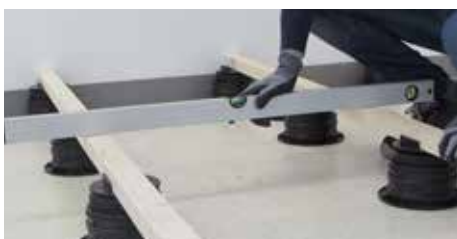
22. Vérifier que l'installation est de niveau.
