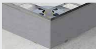
F5. Ajustez le carreau coupé entre le profil BSJ et le clip SUPACLPB.
