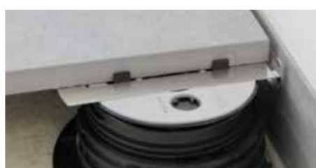
11. Posez le carreau.
