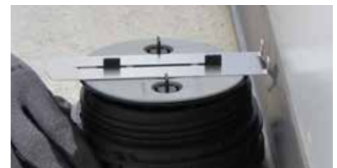
9. Encaje el clip distanciador SUPACLPP entre las dos pestañas perpendiculares hacia la pared.
