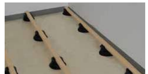
21. Comprobar que la viga esté firmemente fijada en todos los soportes.
