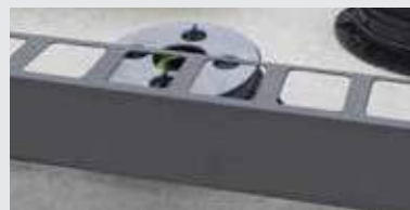
E2. Mettez le profilé BSR entre les ailettes positionnées sur la tête du plot.
