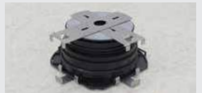
F-3. Sitúe sobre el cabezal del soporte los dos clip SUPACLPT perpendiculares entre ellos.
