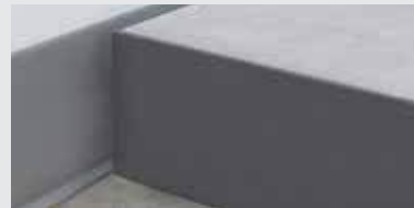
D4. Posez le carreau de couverture.
