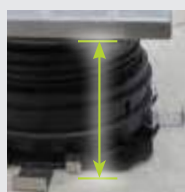
F4. Coupez le carreau de la mesure correspondant l'hauteur entre le profil BSJ et le clip SUPACLPB.
