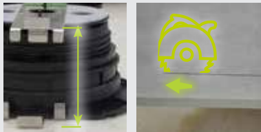
E-4. Corte la baldosa a la medida correspondiente entre SUPACLPT y SUPACLPB.
