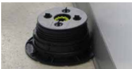
8. Ensamble los soportes y colóquelos con el lado cortado apoyado hacia la pared.
