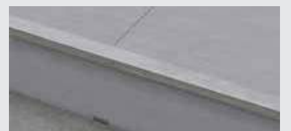
E-6. Colocar la baldosa.
